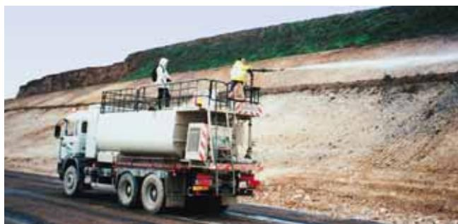
AQUASORB™的一个优点是防止表面纤维覆盖层因土质干燥而硬化，从而保证透气和植物能快速生长。同时，AQUASORB™也能减少纤维覆盖层的用量。
